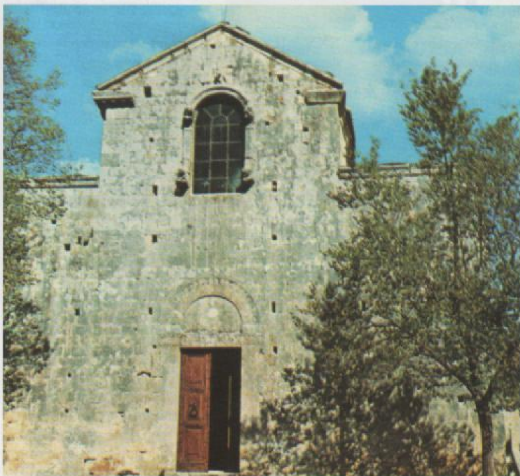
Bominaco - Caporciano (Aq) - Chiesa e Monastero di Santa Maria (sec XII)
